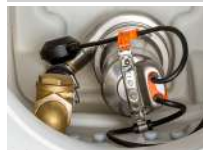
flexCAT 2107 EPT: Zintegrowana pompa wodna wykonana ze stali nierdzewnej.
