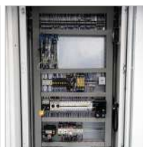
▶ Szafa sterownicza z wysokiej jakości komponentami firm Schneider, Mitsubishi, Delem i Fiessler
