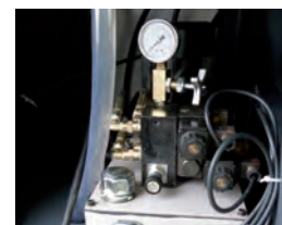
AUTOMATYCZNY SYSTEM CHŁODZENIA
